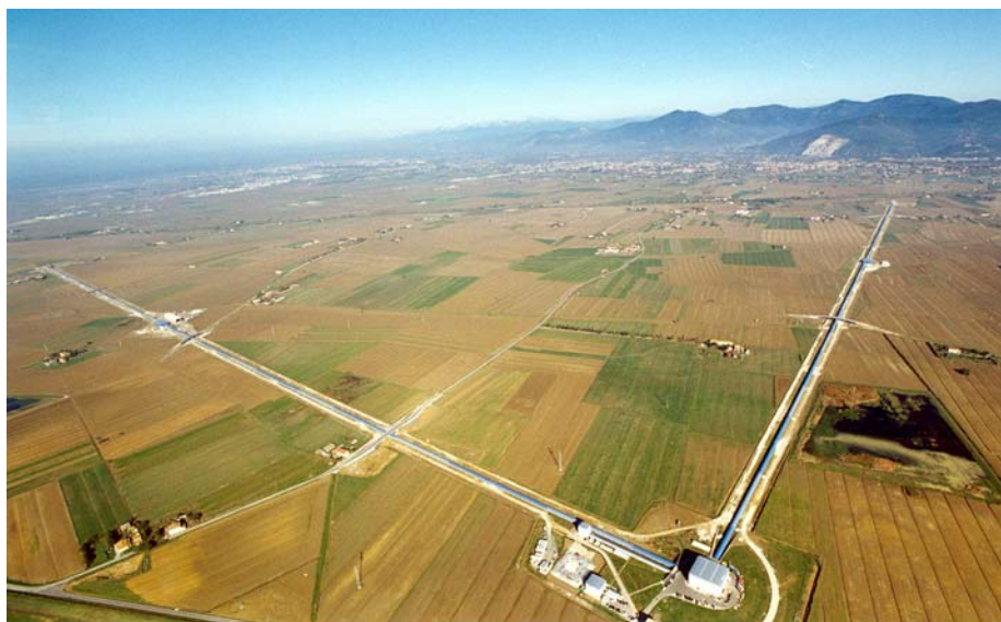
Detektor Virgo widziany z lotu ptaka. Oba ramiona detektora mają długość 3 km, u zbiegu ramion widać budynki stacji. Na horyzoncie po lewej można dostrzec zabudowania Pizy.
